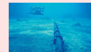
水底ケーブルの長さ ・500km
