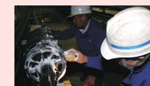
電話線や光ケーブル等の ケーブルの長さ・92万km
